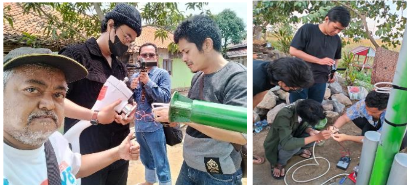
Gambar 3. Pelaksanaan praktek lapangan; pemasangan tiang dan kabel wind turbine oleh masyarakat Desa Pabean Udik dibantu pengabdian dan mahasiswa UPN Veteran Jakarta.
